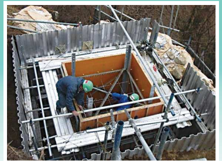
鉄塔の基礎工事
