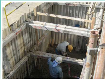
電線共同溝設置工事
