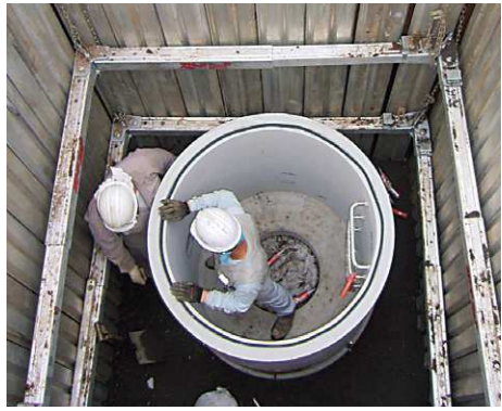
下水道マンホール設置工事
