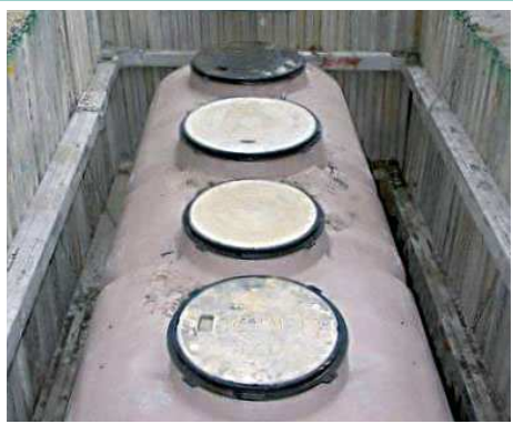
浄化槽設置工事
