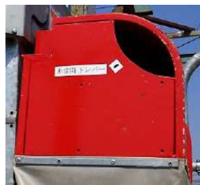
非常降下装置 停電時や電気系トラブル発生時、 手動降下するためのブレーキ 開放装置です
