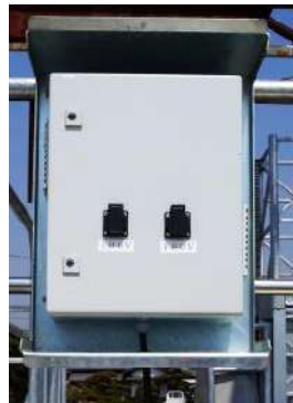
ダウントランス 作業用電源として 100V—3kVA を出力可能
