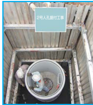
2号人孔据付工事
