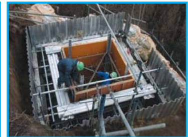
山間部での鉄塔基礎工事
