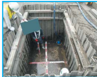
道路際の現場での情報ボックス設置作業
