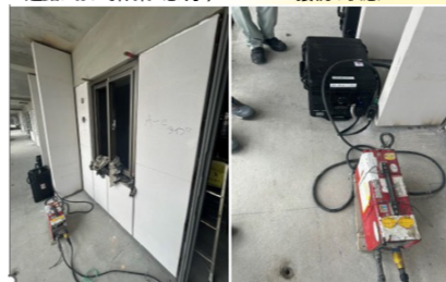
通路において作業 窓(小)
