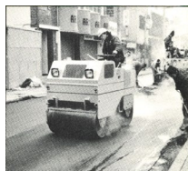
○パイブレーションローラ
