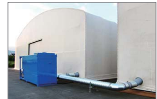
大型倉庫テント(集塵装置取付)
