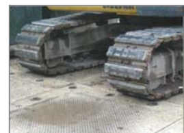
養生資材(メガデッキ)
