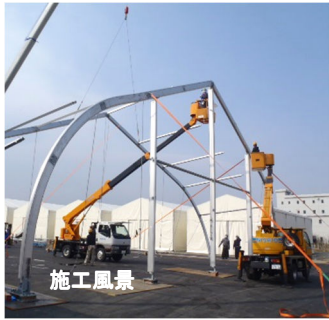
トンネルずり保管 W20m
